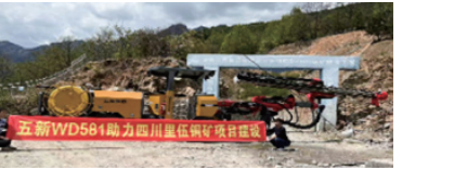
中铁八局四川里伍铜矿 断面: 4.2m×3.8m
