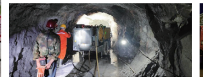
江西新大矿业白云石矿 断面: 5.0m×5.0m
