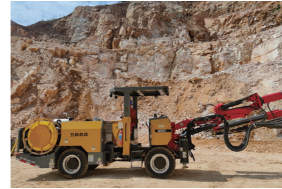
江西新大矿业白云石矿 断面: 5.0m×5.0m
