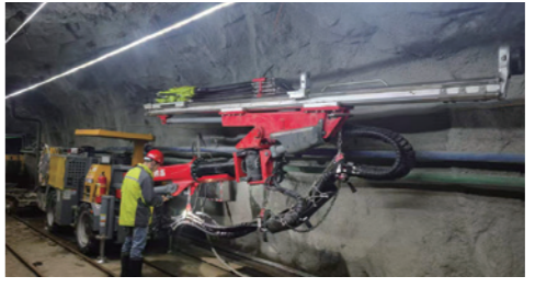
中国黄金内蒙古金涛股份有限公司金矿 断面: 2.4m×2.6m
