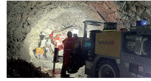
甘肃亚泰矿业铜矿 断面: 2.8m×3.0m
