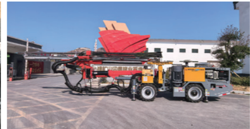
湖南有色锡矿山锑矿 断面: 2.5m×2.5m
