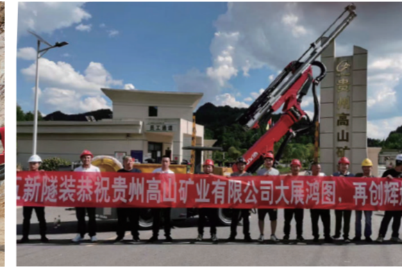
贵州高山矿业磷矿 断面: 3.7m×4.5m / 3.9m×4.9m
