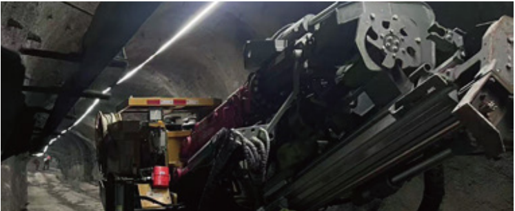
中国五矿山东莱新铁矿 断面: 2.7m×2.7m
