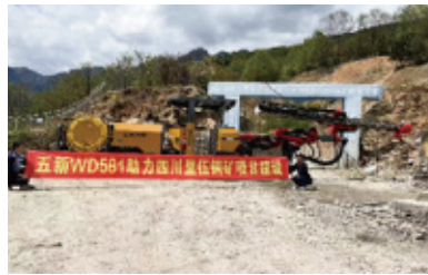
中铁八局四川里伍铜矿 断面: 4.2m×3.8m
