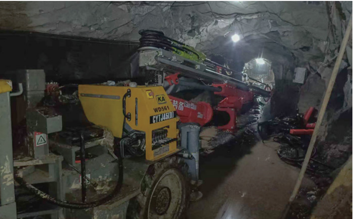
河南洛阳宏邦矿业金矿(极小断面) 断面: 2.2m×2.2m
