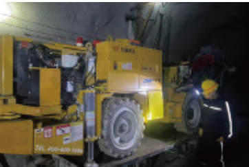
四川新洋丰矿业巴姑磷矿 断面: 3.4m×3.4m
