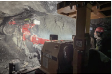
河南洛阳某铅锌矿 断面: 3.0m×3.0m
