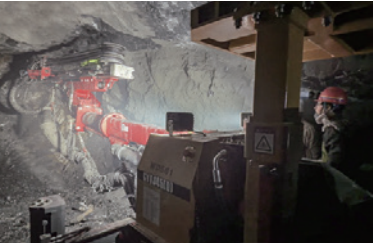
河南洛阳某铅锌矿 断面: 3.0m×3.0m
