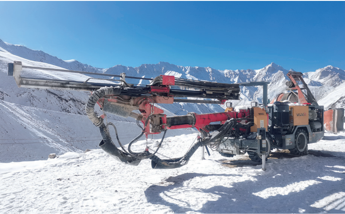
新疆地矿屈库勒克东金锑矿(高寒、高海拔) 断面: 2.5m×2.5m
