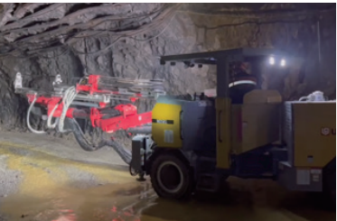
中亚某镍钴矿 断面: 4.4m×3.9m / 4.5m×4.0m
