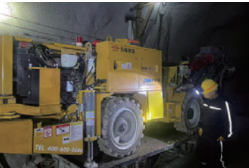
四川新洋丰矿业巴姑磷矿 断面: 3.4m×3.4m
