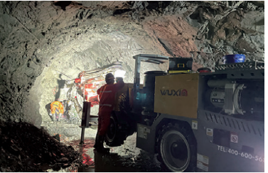
甘肃酒泉亚泰矿业白山铜矿 断面: 2.8m×3.0m
