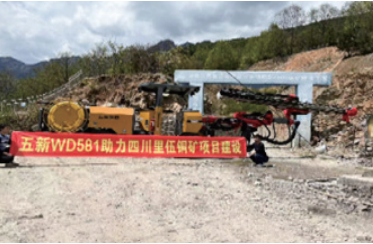
中铁八局四川里伍铜矿 断面: 4.2m×3.8m
