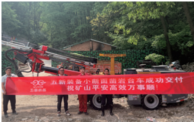
河南发恩德矿业铅锌银矿 断面: 3.2m×3.6m
